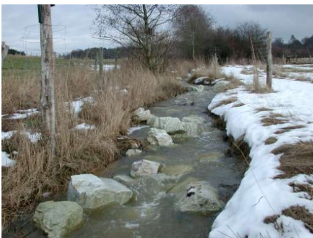
Wo früher das Wasser geradlinig und schnell Richtung Ortsmitte floss, wird es heute durch Mäander und „Störsteine“ ausgebremst.
